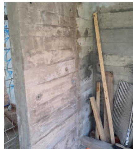
Neues Wandstück mit der bestehenden Optik.
