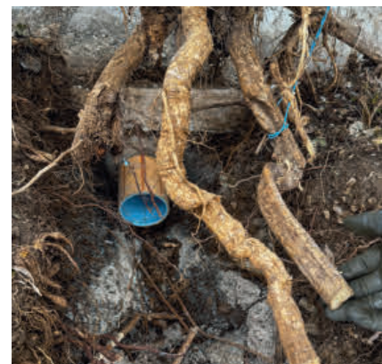
Aufgrund des starken Wurzeleinwuchses musste die Abwasserleitung saniert werden.
