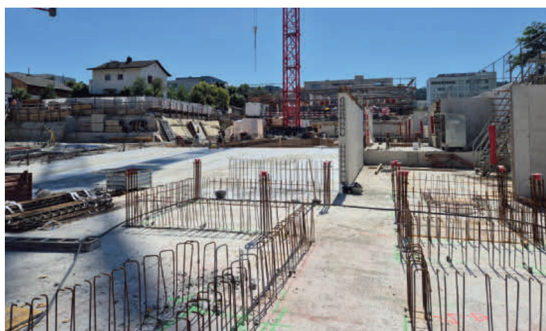
Die Rohbauarbeiten von Haus 2 schreiten voran.
