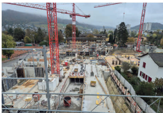
Blick auf die Baustelle von Haus 2 und 4 der ersten Etappe.
