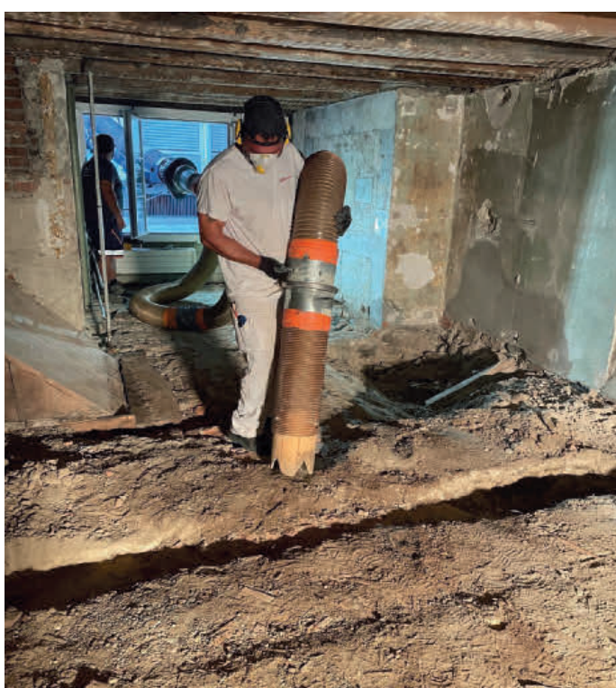
Freilegung des Kellergewölbes mittels Saugbagger.
