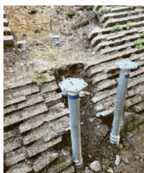
Schraubenfundamente für Montage einer Wärmepumpe
